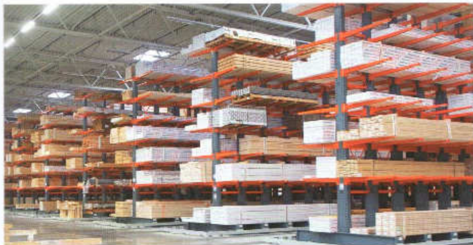
Zentrales, automatisiertes Lager mit Kragarmregalen der Firma Sipag. Bilder: Martin Binkert
